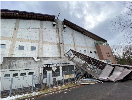
サンアリーナは自衛隊の備蓄庫として利用。RC片持ち架構が構面外変形し屋根架構損傷
