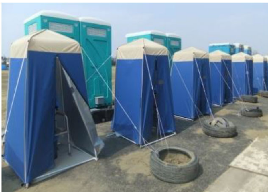
写真6.2.1 マンホールトイレの設置例 1)
