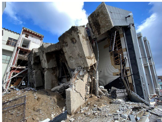
河合町の倒壊RC7階建て建物。
