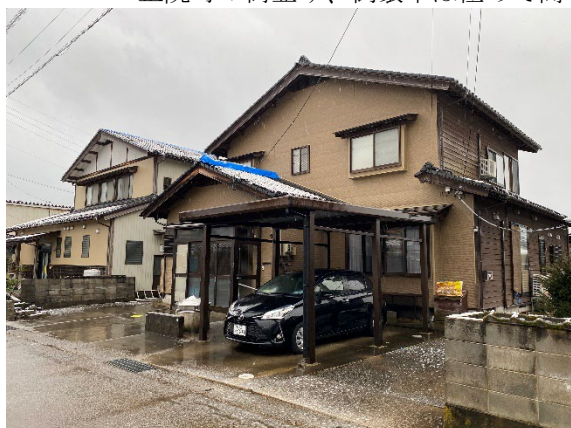
珠洲市内：耐震補強(左)、新築(右)で無被害の住宅も少数が見られる
