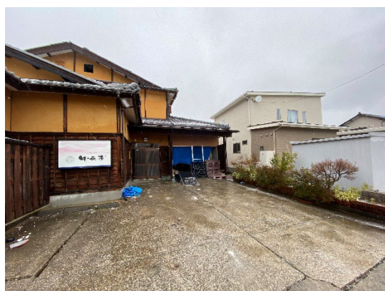
珠洲市内：耐震補強(左)、新築(右)で無被害の住宅も少数が見られる
