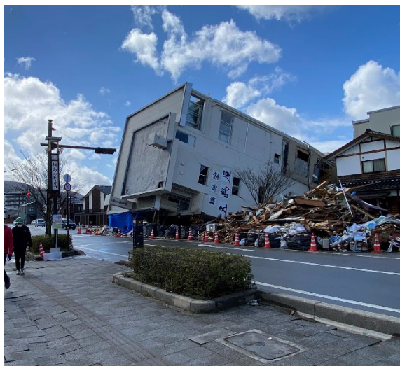
周辺地盤では軟弱粘性土の圧密沈下の様子が見られる
