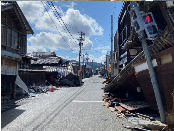
いろは橋護岸の損傷と上町の被災状況。一層崩壊が典型的
