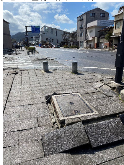
周辺地盤では軟弱粘性土の圧密沈下の様子が見られる
