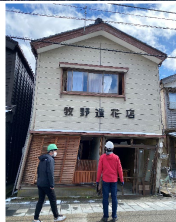
いろは橋護岸の損傷と上町の被災状況。一層崩壊が典型的
