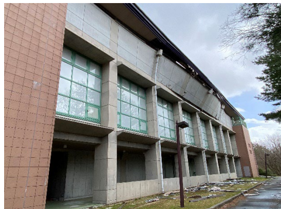
サンアリーナは自衛隊の備蓄庫として利用。RC片持ち架構が構面外変形し屋根架構損傷
