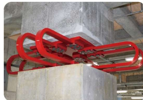
地下免振装置 免震構造の採用により高い耐震性能を有しているため、大規模地震などにおいても、災害応急対策や通常業務を継続して行うことができます。
