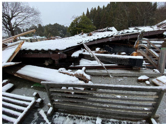
珠洲市内西勝寺本堂の倒壊 壁の少ない寺社建築は倒壊率が高い
