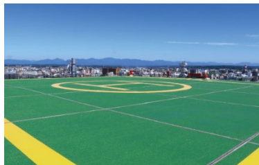
屋上ヘリポート
