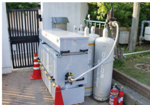
図4.9.3 移動式ガス発生設備による臨時供給の事例 （出典：大阪ガスネットワーク株式会社ホームページ）
