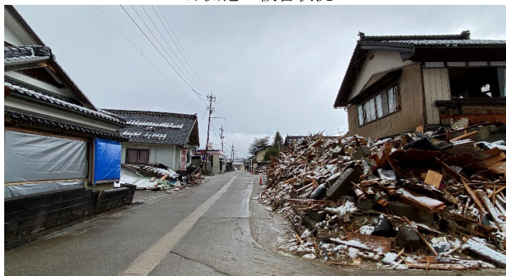
正院町の被害状況
