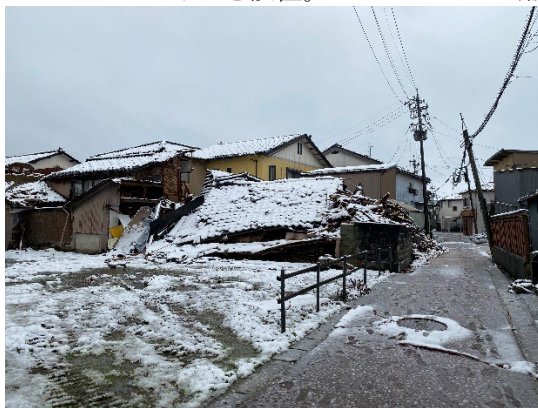
珠洲市内の被害
