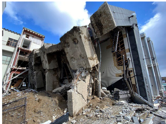
河合町の倒壊RC7階建て建物。
