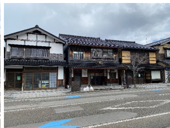
無被害に見える建物もある
