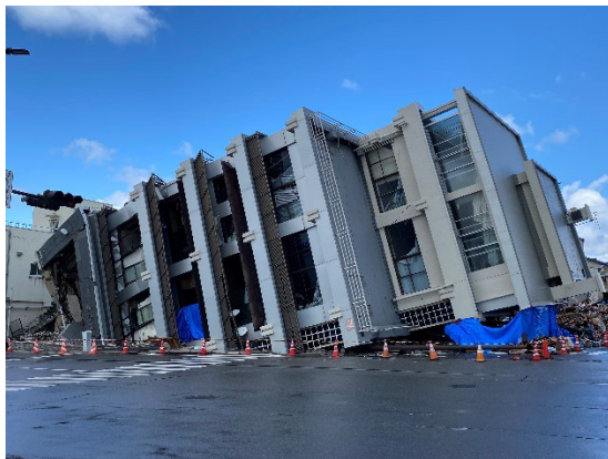
河合町の倒壊RC7階建て建物。
