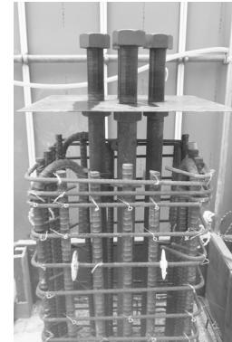
図 18 C1 柱施工写真
