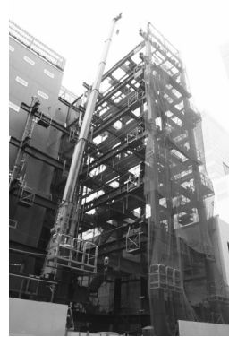
図 16 鉄骨建方工事写真
