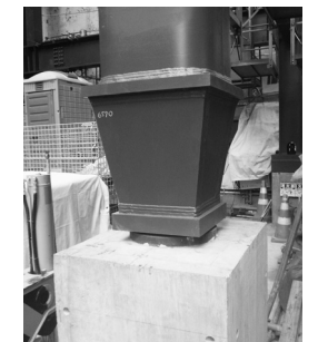
図 21 C2 柱建方工事写真
