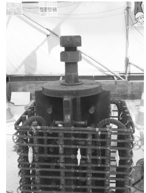
図 19 C2 柱施工写真
