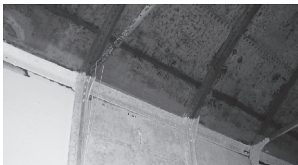
図7 霧笛舎内部軒廻り詳細(屋根面に筋状の溶接跡あり)
