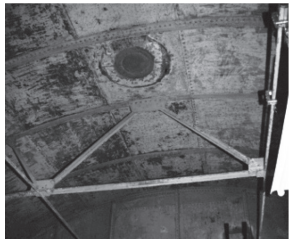
図9 旧ラッパ位置の補修跡
