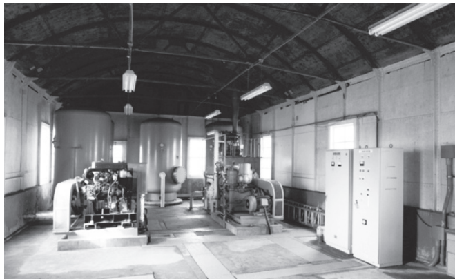
図 2 犬吠埼灯台霧笛舎 現状内観（北側を見る）
