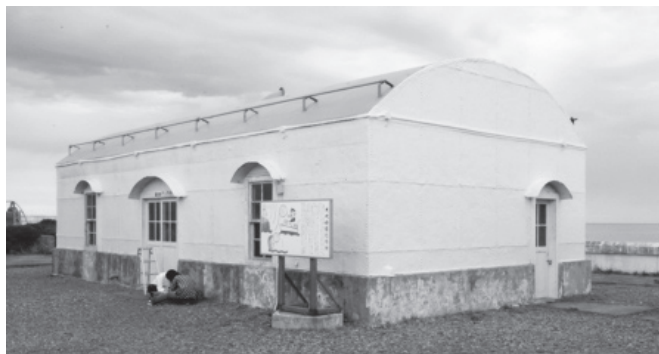
図 1 犬吠埼灯台霧笛舎 現状外観（西面・南面）
