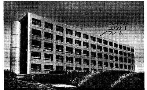
(c) Type3:強度型PCフレーム補強
