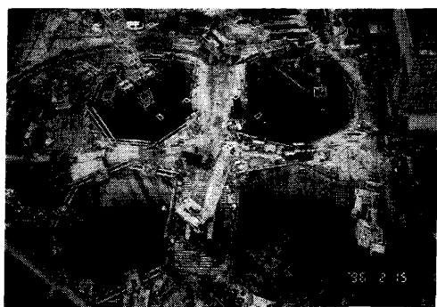
写真3：基礎ケーソン施工状況
