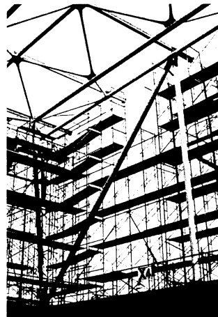
図17 制振ブレース建て方状況
