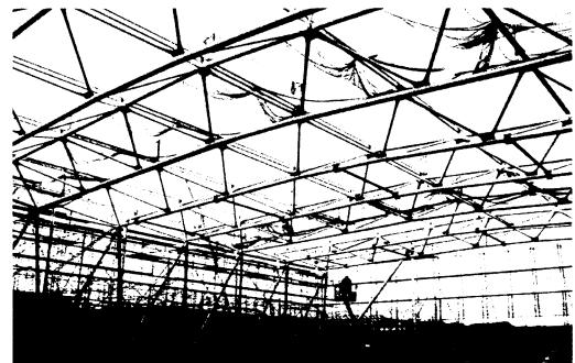
図16 立体トラス架構建て方状況（内観）
