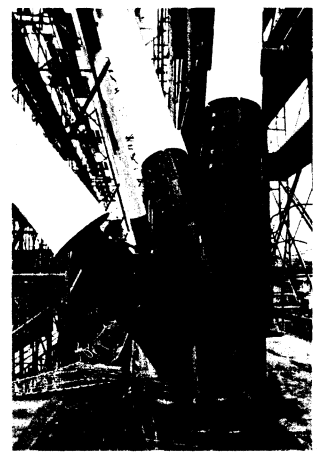
図18 制振ブレース柱脚側接合部
