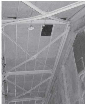
写真 2 J 通り屋根ブレース座屈
